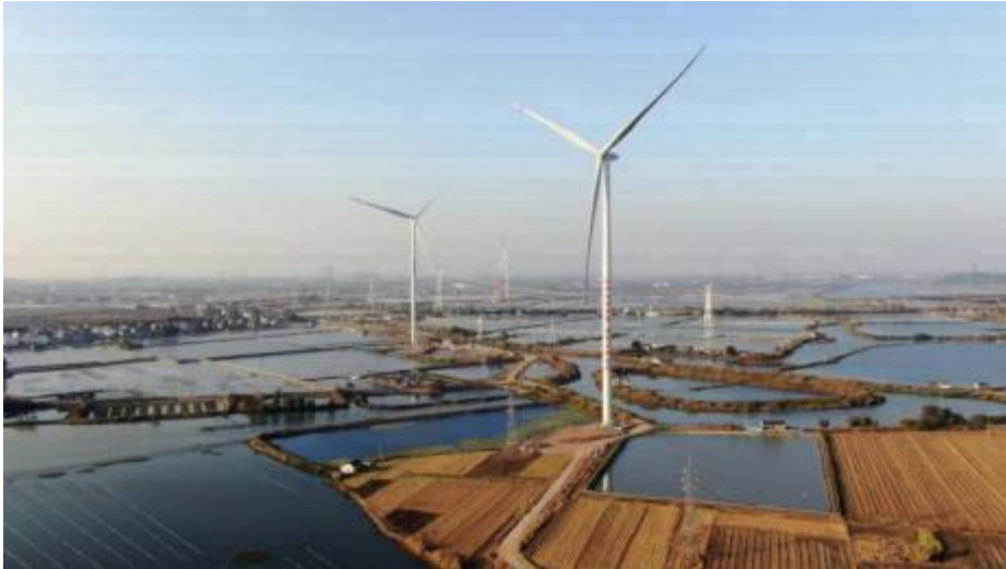
图杨巷镇稻田分散风力发电项目
